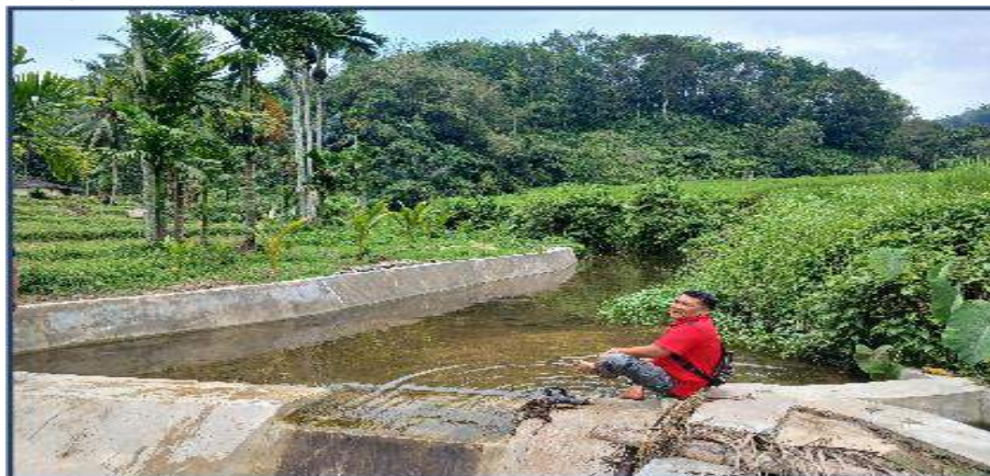
Kegiatan pembangunan dan parit di Nagari Indudur Kec. IX Koto Sungai lasi
