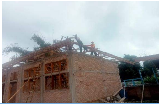
Pembangunan Ruang Kelas Baru Sekolah Dasar
