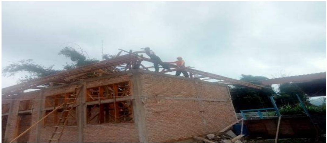
Pembangunan Ruang Kelas Baru Sekolah Dasar
