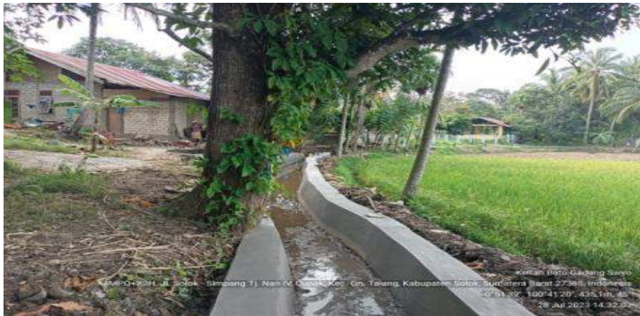
Kegiatan rehabilitasi jaringan irigasi tersier Irigasi Irigasi Sawah Nyanta di Banda Putih Jorong Koto Kaciak Nagari Muaro Paneh Kecamatan Bukit Sundi
