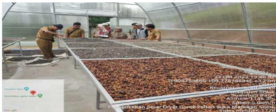
Bangunan solar dryer dome di kelompok tani sukamaju nagari Sirukam kec. Payung Sekaki
