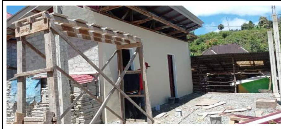
Survei dan konsultasi Rumah Tidak Layak Huni (RTLH), 2023
