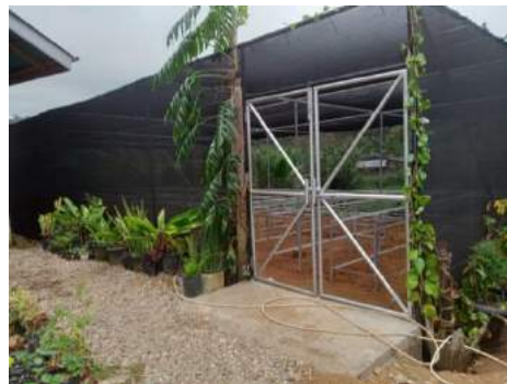
Kegiatan pembangunan screenhouse di nagari Batang baru Kec. Gunung Talang
