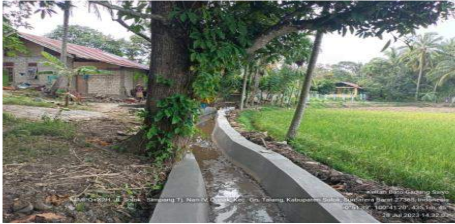
Kegiatan rehabilitasi jaringan irigasi tersier Irigasi Irigasi Sawah Nyanta di Banda Putuuh Jorong Koto Kaciak Nagari Muaro Paneh Kecamatan Bukit Sundi
